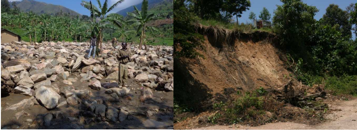
Ces pierres descendues des montagnes ont bloquées la route et causant éboulement et glissement de terre
